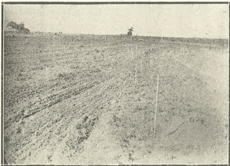
Foto I — Locação dos pontos de nível, produzindo uma curva muito irregular.
