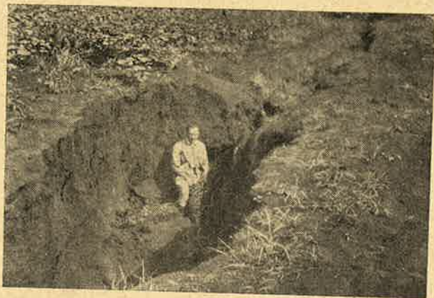
Fig. 1 — Esta grande vala foi ocasionada em virtude das exiguas dimensões do canal de escoamento. Fatos como este são comuns quando os canais não são projetados e construídos com o perfeito senso de suas necessidades.
