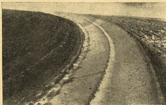
Fig. 1 -- Às vezes um sistema de terraços bem construídos, como este, fica comprometido e prejudicado por defeitos no traçado e construção de apropriados canais escoadouros.
