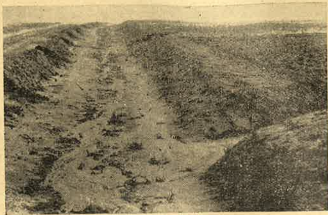
Fig. 2 — Um canal, paralelo a um carreador. A inclinação dos lados aqui não está conforme e apenas metade do canal foi plantado e muito raramente. Essa vegetação possivelmente não cobrirá toda a extensão do canal, em tempo oportuno.
