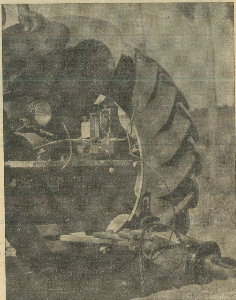
Fig. 1 — Dinamógrafo acoplado ao trator
