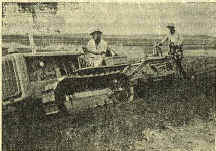
Fig. 1 — Fase da construção de um terraço de base larga construído dum lado só (Fazenda São Geronimo — Limeira)
