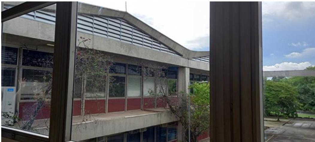
Foto da fachada - vigas externas do parabolóide e da grelha, dos pilares e das venezianas na cobertura
