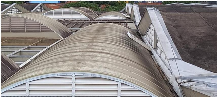
Foto das coberturas com domos de policarbonato, venezianas e parabolóides em concreto
